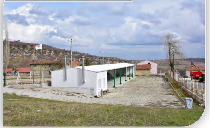
DEREYALAK MAHALLESİ SOSYAL TESİS
