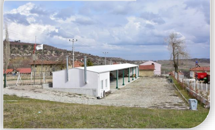
DEREYALAK MAHALLESİ SOSYAL TESİS
